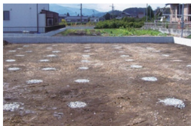
施工後の地盤（住宅）
